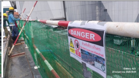
รูปที่ ๗7.55 นั่งร้านเหล็กซึ่งด้วยผ้าใบ เพื่อป้องกันเศษวัสดุร่วงหล่น
