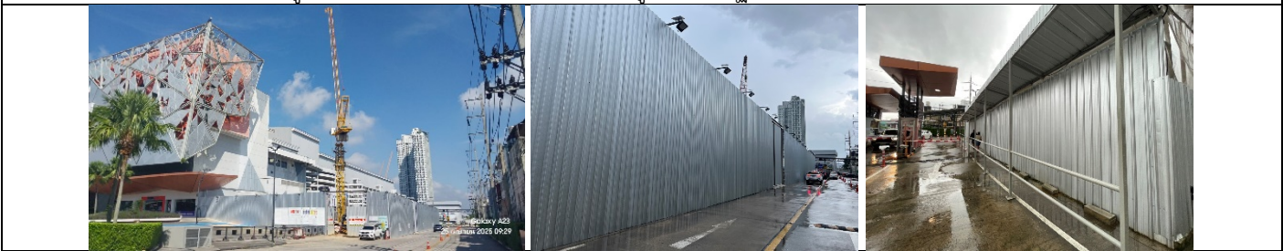
รูปที่ ๗7.10 รั้วทึบกันบริเวณพื้นที่ก่อสร้าง
