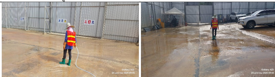
รูปที่ ผ7.5 เจ้าหน้าที่ฉีดพรมน้ำเพื่อลดฝุ่น
