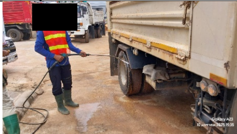
รูปที่ ผ7.13 เจ้าหน้าที่ทำความสะอาดล้างล้อรถบรรทุก
