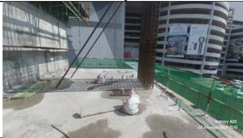
รูปที่ ๗7.55 นั่งร้านเหล็กซึ่งด้วยผ้าใบ เพื่อป้องกันเศษวัสดุร่วงหล่น
