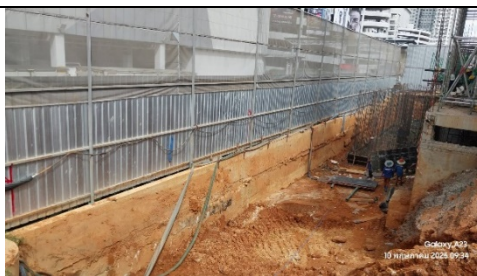
รูปที่ ผ7.1 กำแพงกันดินตลอดแนวอาคารชั้นใต้ดิน
