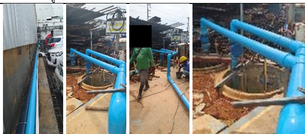
รูปที่ ผ7.2 ท่อระบายน้ำชั่วคราว และบ่อดักตะกอน
