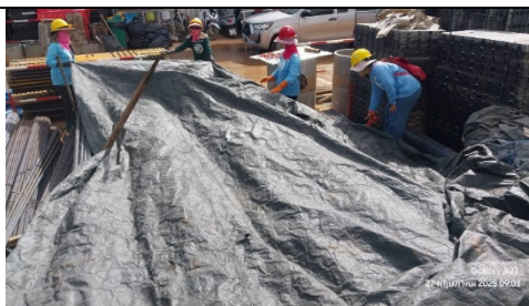
รูปที่ ๗.20 ปิดคลุมเศษวัสดุก่อสร้างด้วยผ้าใบ
