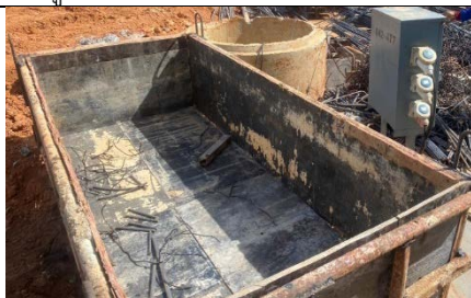
รูปที่ ๗.24 การเก็บกองทรายในบ้น (Bund)
